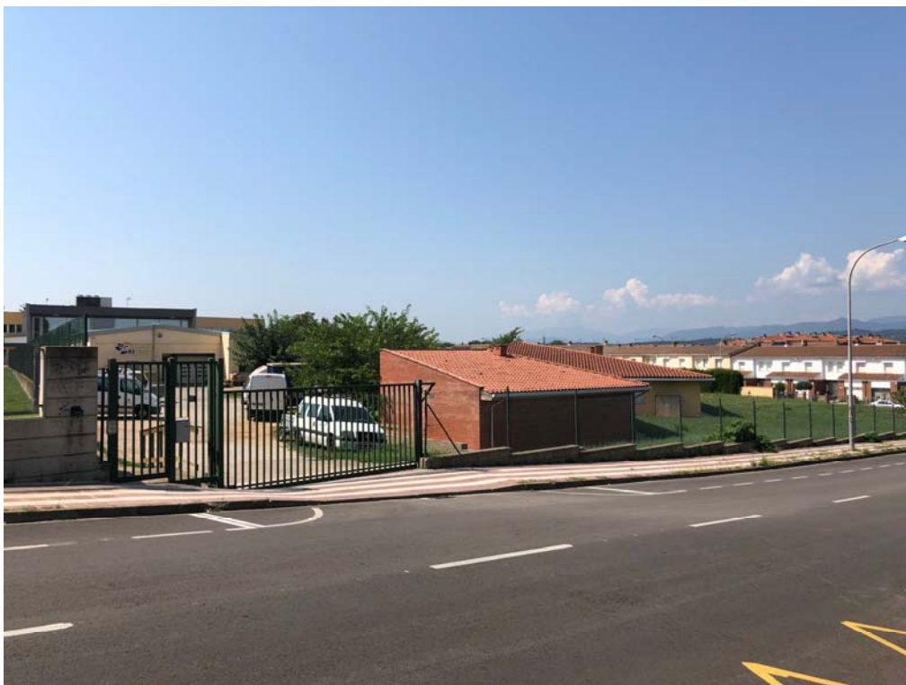
Fotografia de l'entorn de l'edificació amb accés pel Carrer Riu Cardener, 32.
