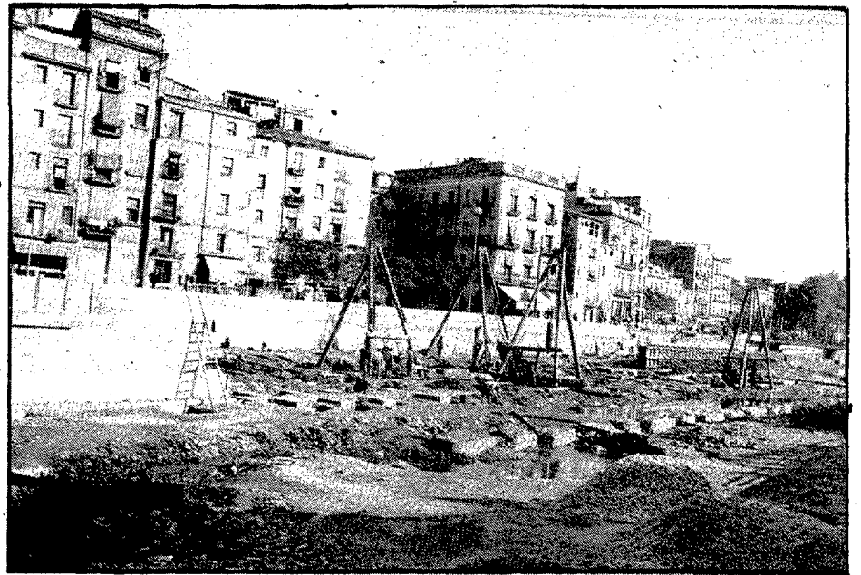
Fotografia de l'any 1966, quan van començar les obres de construcció de la plataforma sobre l'Onyar (Foto: Arxiu d'imatges de l'Ajuntament de Girona)
