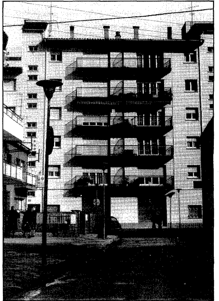
L'edifici Llúcia és l'única excepció en un carrer format exclusivament per cases unifamiliars. (Fotos: Lladó).
