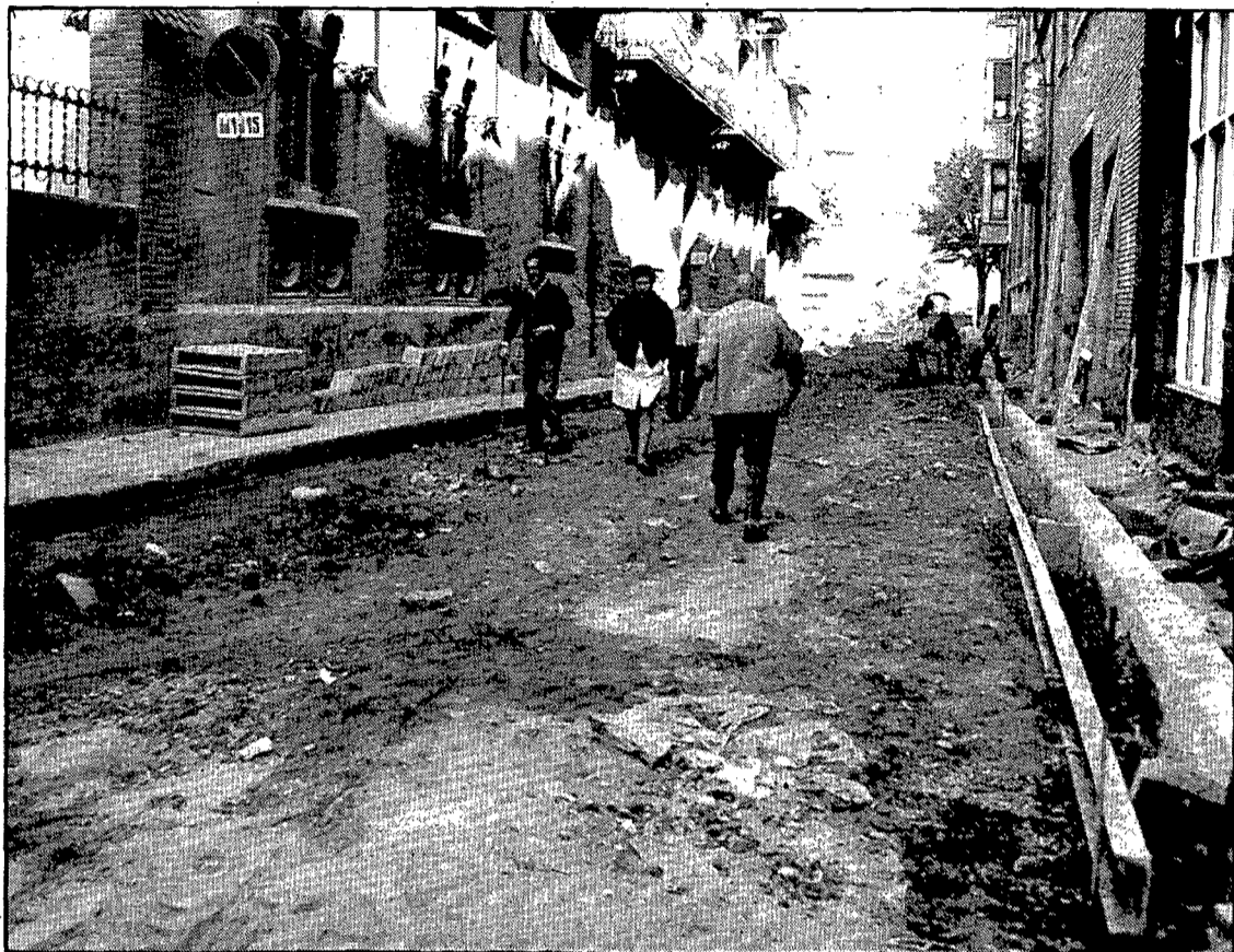
El carrer, amb el paviment aixecat, durant les obres d'urbanització de l'any 1973 (Foto: Arxiu d'imatges de l'Ajuntament de Girona).
