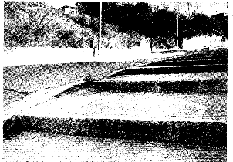
El fort desnivell de les voravies és resolt amb amplis esglaons. Foto: Rafael Bosch
