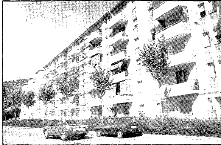
El bloc de pisos de promoció pública construït on hi havia l'estació del carrilet de Palamós
