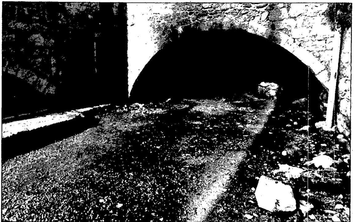
El carrer de Trasfiguera enllaça la plaça de Sant Feliu i el carrer del Portal de la Barca
