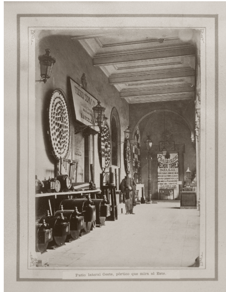
Exposició Catalana de 1877. Pati lateral oest, pòrtic que mira a l'est.
