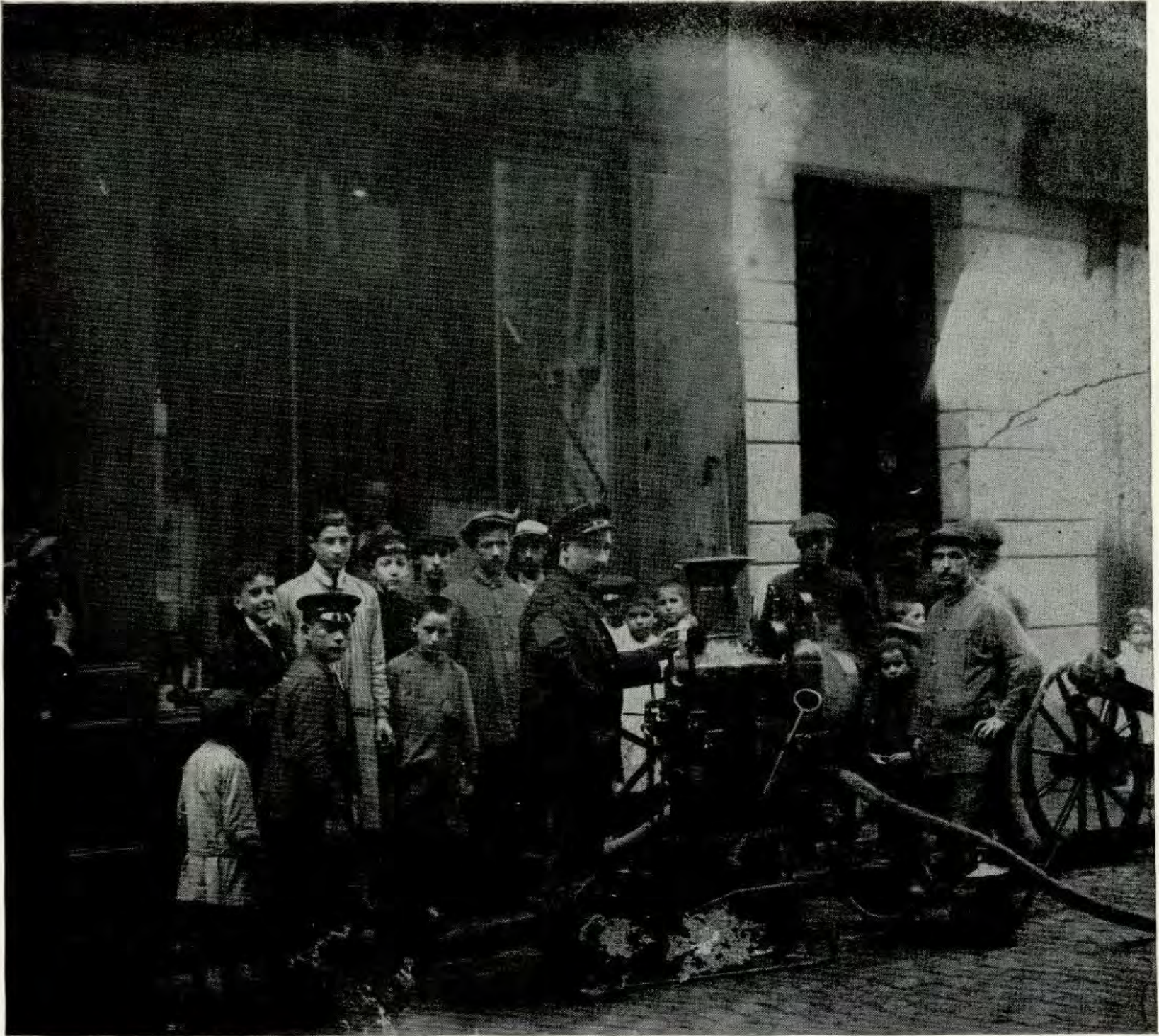
Trabajo con una bomba de vapor en la Calle Platería
