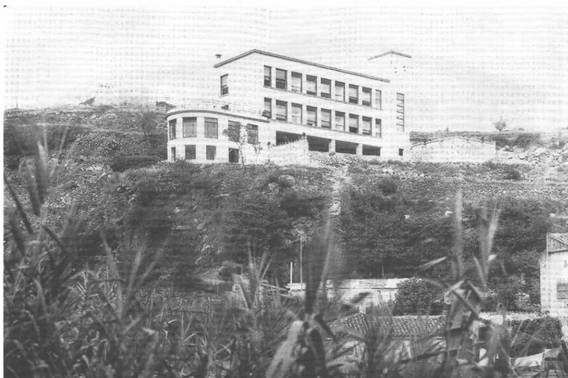
Imatge 1: façana sud de l'edifici de l'escola Ignasi Iglésias amb la torre de Suchet al fons (AIEMB).
